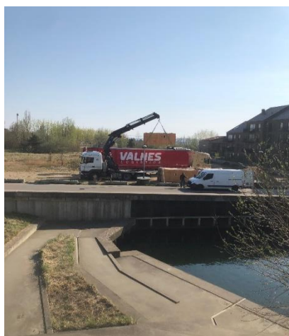
De printede betonelementer blev leveret. Foto: Torben Mølkjær.
