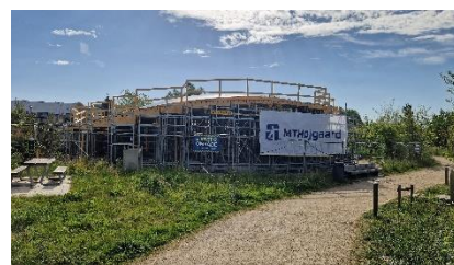
Der bliver ikke sat rekord i hurtigt byggeri, men vi håber, at huset snart er færdigt. Foto: Jan Jespersen.
